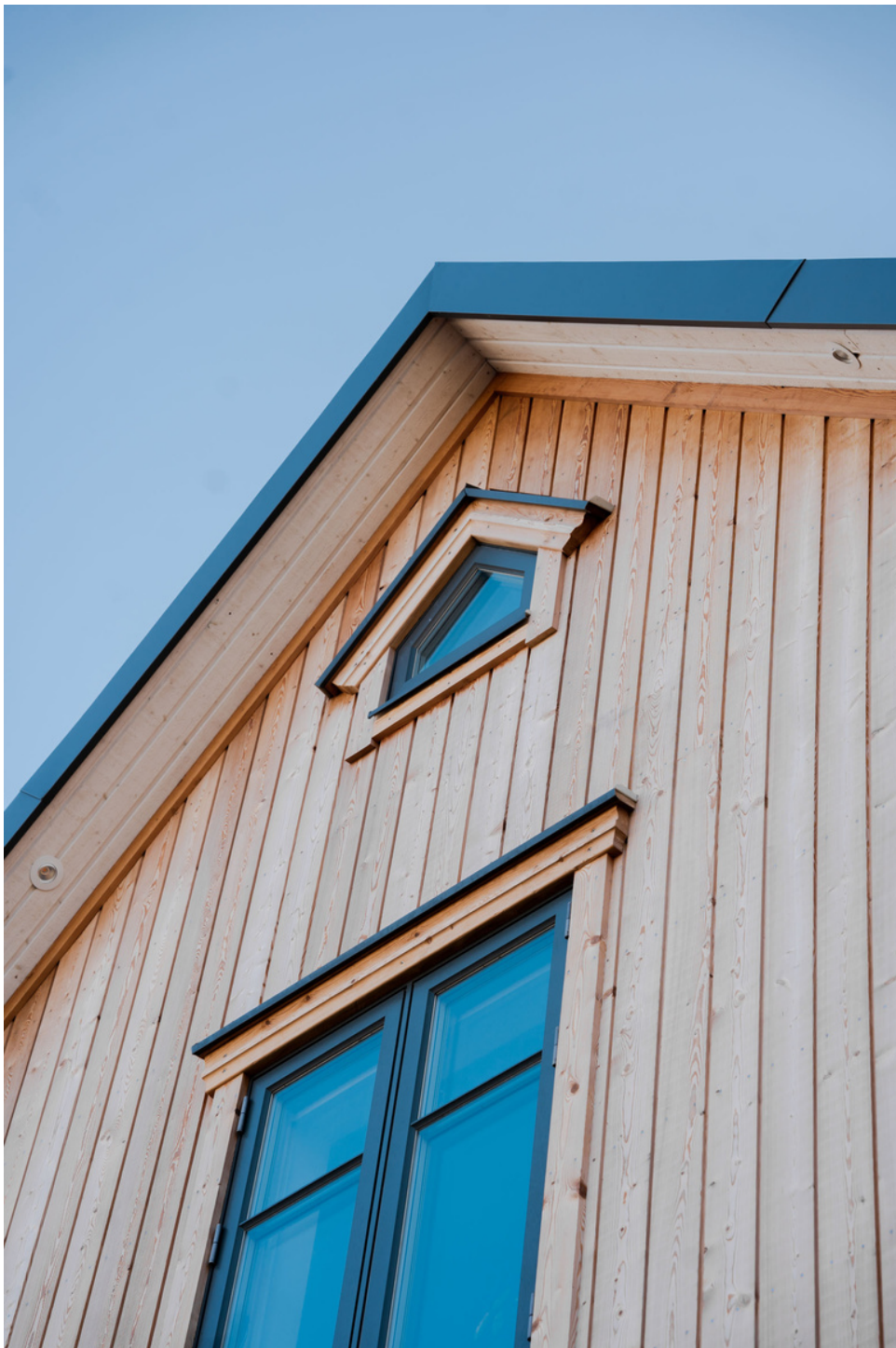
Naturfärgad sibirisk lärk, grå bandtäckt plåt och gråa fönster
